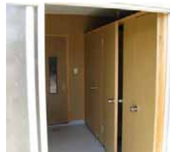
写真は従業員用（健常者も利用する）のトイレの整備事例（岐阜県高山市M農園）。
