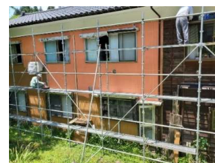
UNEHAUS 外壁塗装
