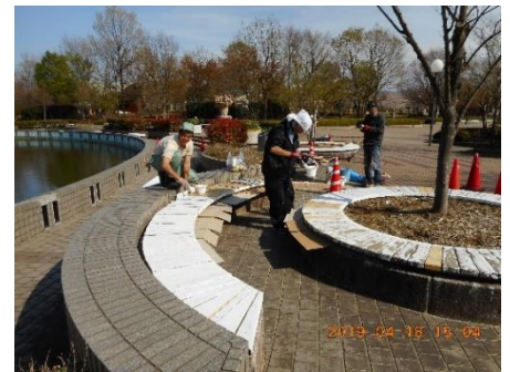
ふるさとの森 ベンチ補修作業
